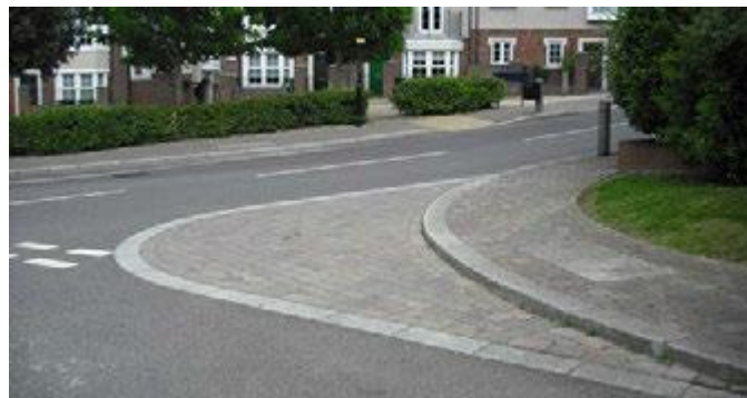
图7.10 大缘石半径改造为小缘石半径
