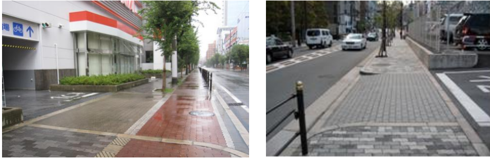
图7.13 机动车出入口的正确处理
